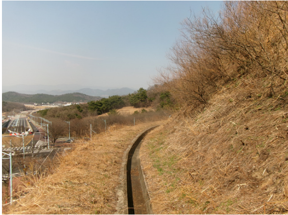
1소단 배수로 전경
