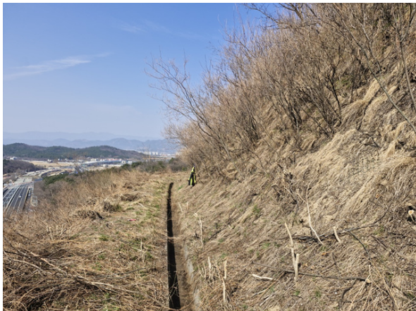
3소단 배수로 전경
