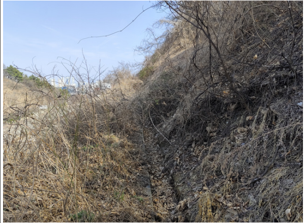
2소단 배수로 전경
