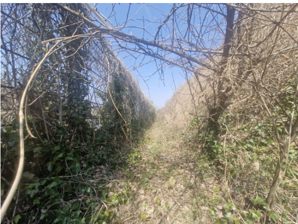
낙석방지울타리 및 하부 전경
